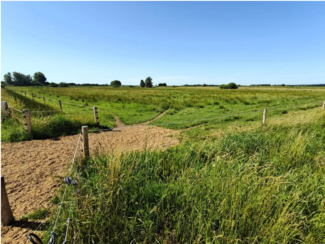
Neue Zäune wurden gesetzt, damit die Rinder – die sich beim Fototermin auf der weitläufigen Anlage verstreut hatten – nicht ausbrechen können. FOTO: CHRISTIAN LIPOVSEK
